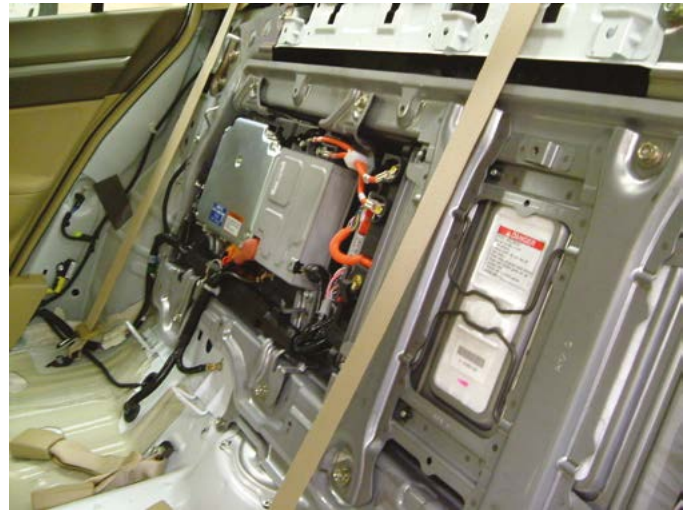
FIGURE 10-1 La batterie haute tension et les commandes du moteur situées derrière la banquette arrière d'une Honda Civic.
